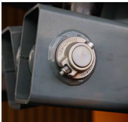
Traitement anti-corrosion des axes, de la visserie et des pièces peintes
